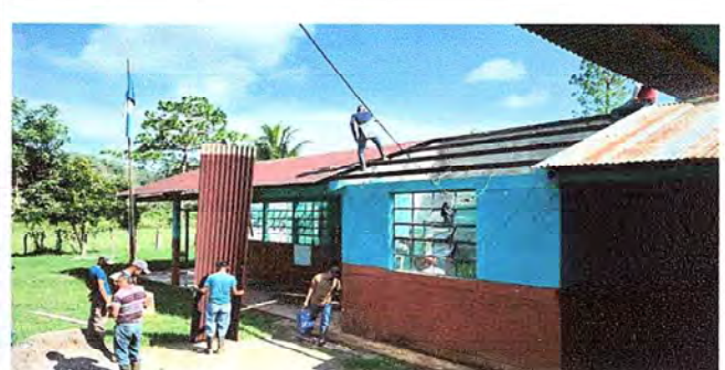
Foto 4: Continuación del desmontaje de láminas y pintura de costaneras.
