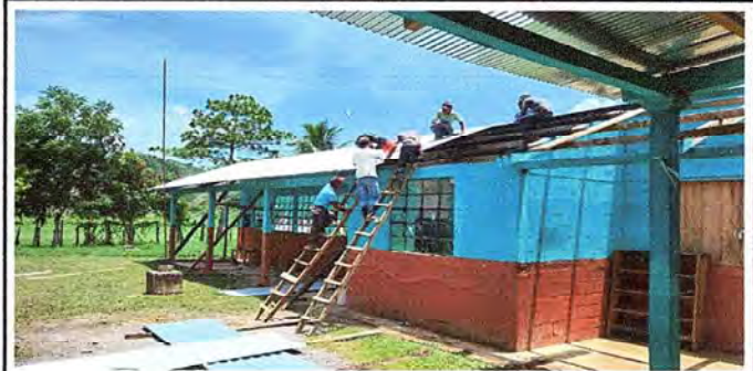
Foto 6: Colocación y atornillado de láminas nuevas troqueladas calibre 28.
