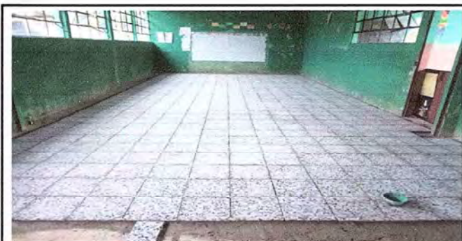
Foto 6: Avance de la colocación de piso de granito en las aulas del primer módulo.
