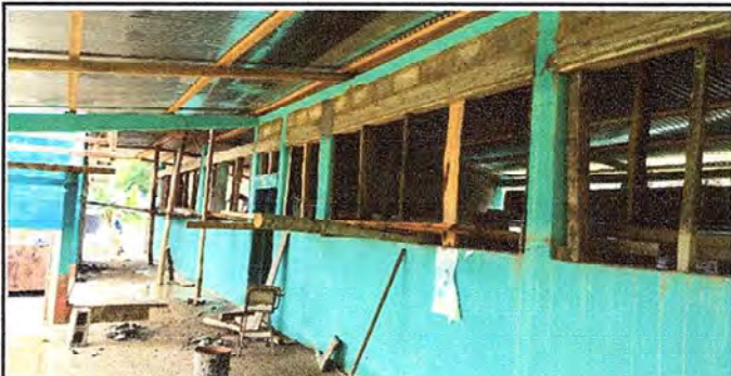
Foto 1: Incio de trabajos de remodelación, nivelación y colocación a escuadra de las áreas a colocar las vetanas con vidrios y las puertas de metal.
