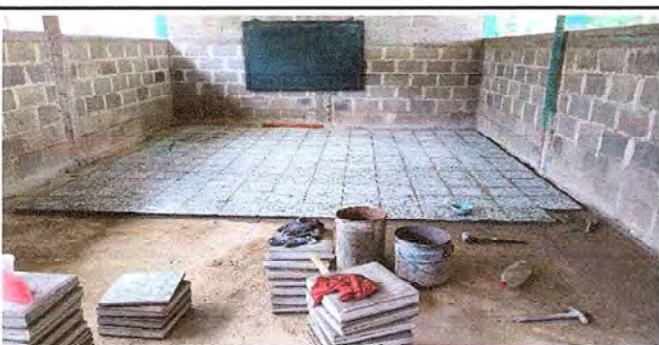
Foto 5: Inicio de sustitución de piso de torta de cemento por piso de granito en las aulas del segundo módulo.
