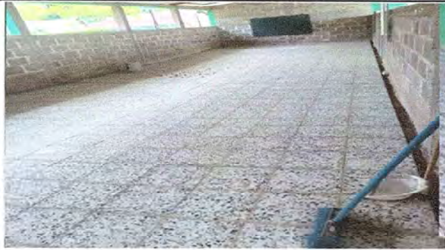
Foto 1: Realización de acabados y bordes para el piso de granito en las aulas del segundo módulo.
