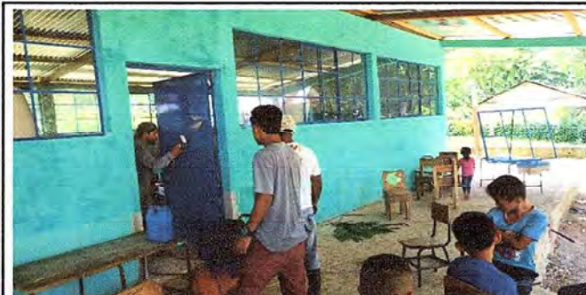
Foto 4: En esta fotografia podemos observar el inicio de la colocación de vidrios, colocación y pintura de puertas de metal.
