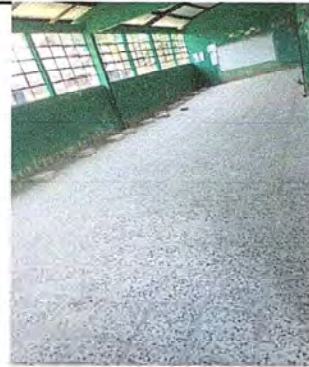
Foto 2: Avance en los acabados finales de la colocación de piso de granito en las aulas del primero módulo.
