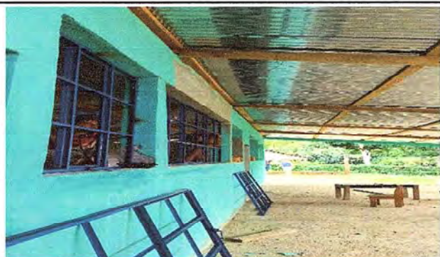
Foto 3: Inicio de soldadura de marcos para las ventanas.
