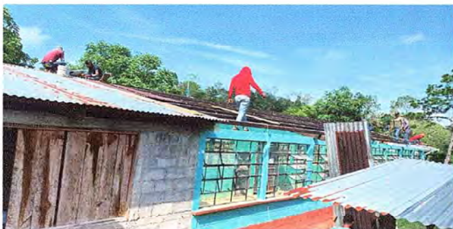
Foto 3: Inicio del desmontaje de las láminas deterioradas y oxidadas. Inician a pintar las costaneras con pintura negra anticorrosiva para prolongar su utilidad.
