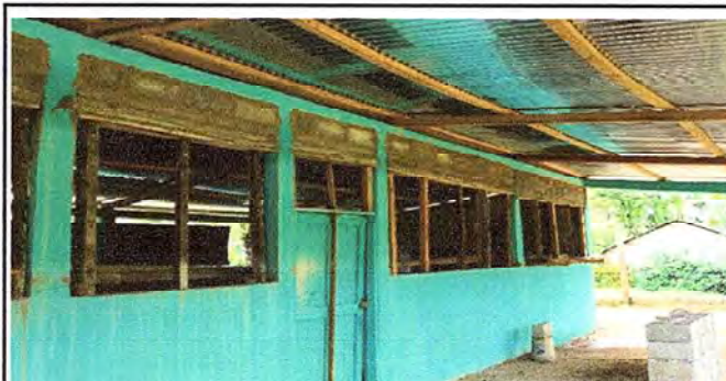
Foto 2: Se colocó una hilera de block y una solera en las areas a trabajar para poder sujetar las ventanías.
